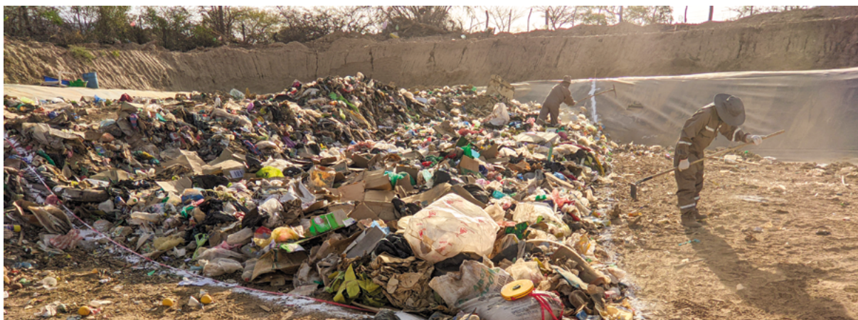
Figura 41. Distribución y conformación de residuos en celda.
