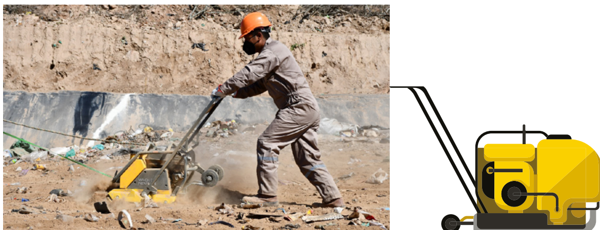
Figura 34. Compactador mecánico manual / pisón de metal
