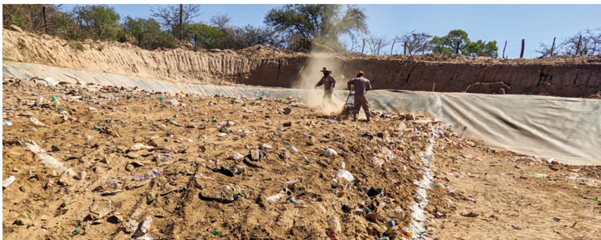
Figura 53. Cobertura final de la celda.
