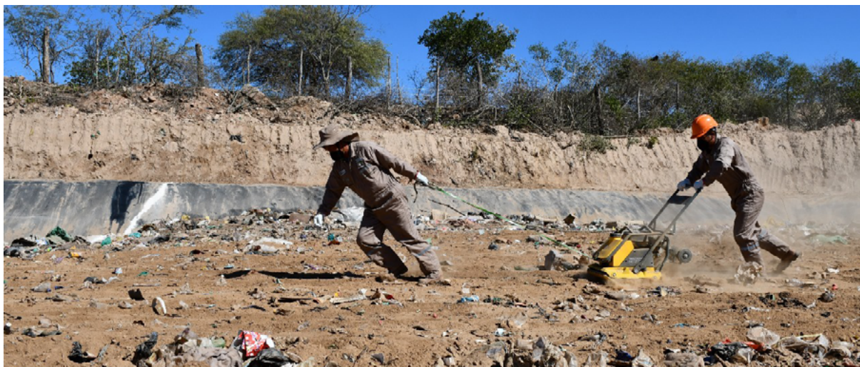
Figura 56. Cierre parcial subcelda trinchera.
