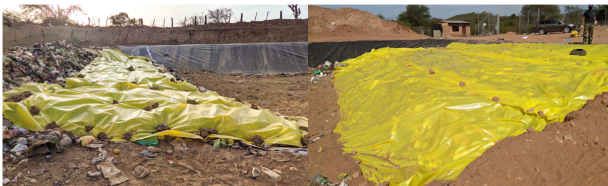
Figura 51. Tendido de geo sintéticos en celda diaria.
