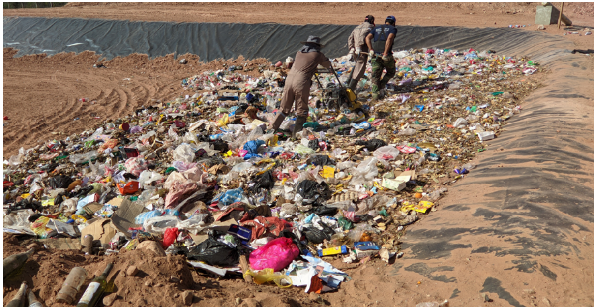
Figura 45. Compactación de residuos.
